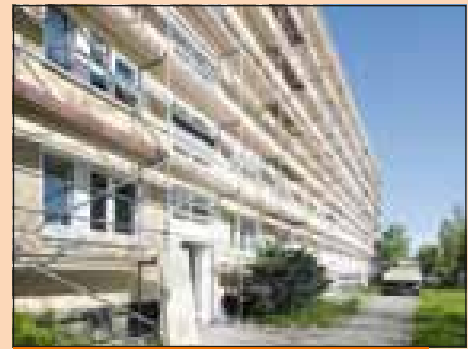
Die Ernst-Enge-Str. 12-16 während der Sanierung
