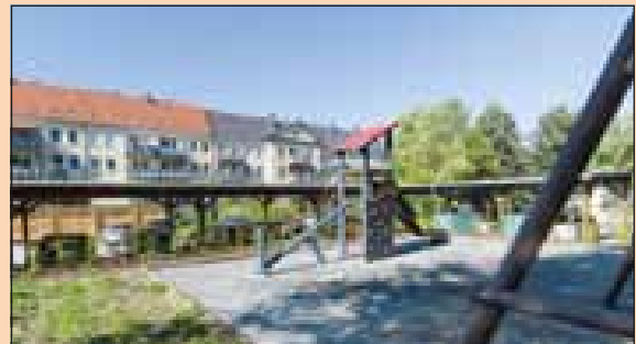
Der Spielplatz während der Bauphase
